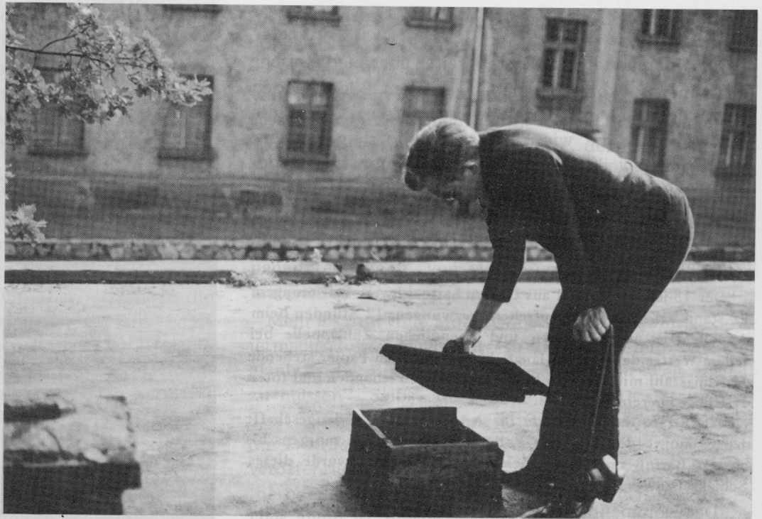
Primitiver Luftschachtdeckel aus Holz und Teerpappe auf dem Dach der angeblichen ehemaligen "Gaskammer" im eh. Stammlager in Auschwitz. Im Hintergrund in unmittelbarer Nähe das Gebäude, hinter dem sich die große Lagerküche befand. — Ein Besucher überzeugt sich davon, wie man hier Zyklon-B hätte hineinwerfen, abdichten und täglich wieder hätte entlüften können.
